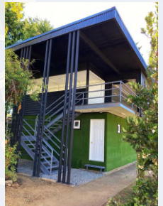
❖ Construcción y montaje de oficina utilizando contenedores.
