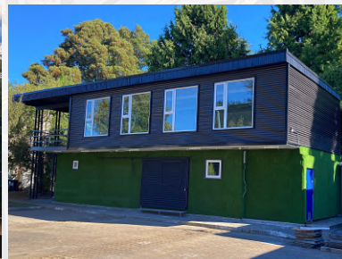
❖ Construcción y montaje de oficina utilizando contenedores.
