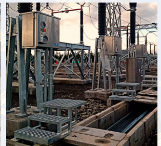
❖ Fabricación de parrillas de operador para subestación Montenegro.
