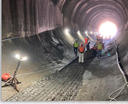
❖ Reparación de acueducto Central hidroeléctrica Pilmaiquén. Statkraft
