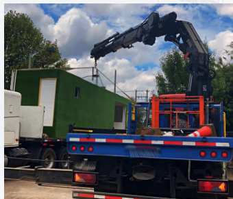
❖ Construcción y montaje de oficina utilizando contenedores.
